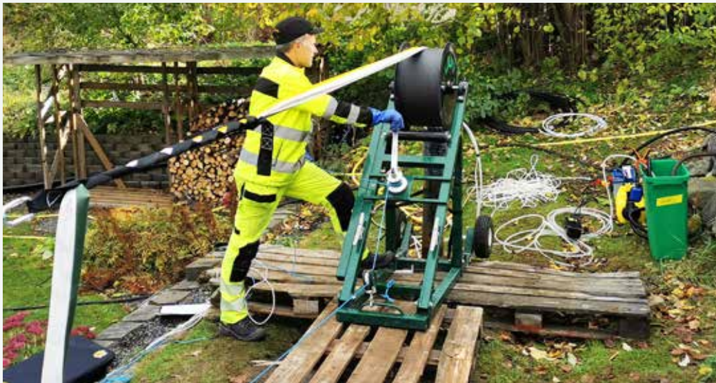
Installation av FLUTe Liners i borrhål
